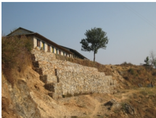
Opěrná zeď u školy ve vesnici Čhjárpa
